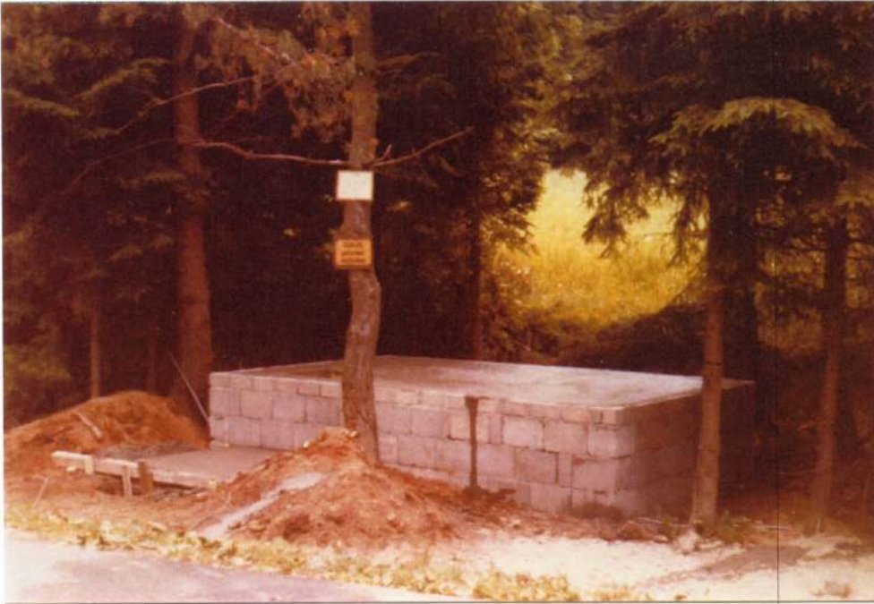
Fundament des Gerätehauses
