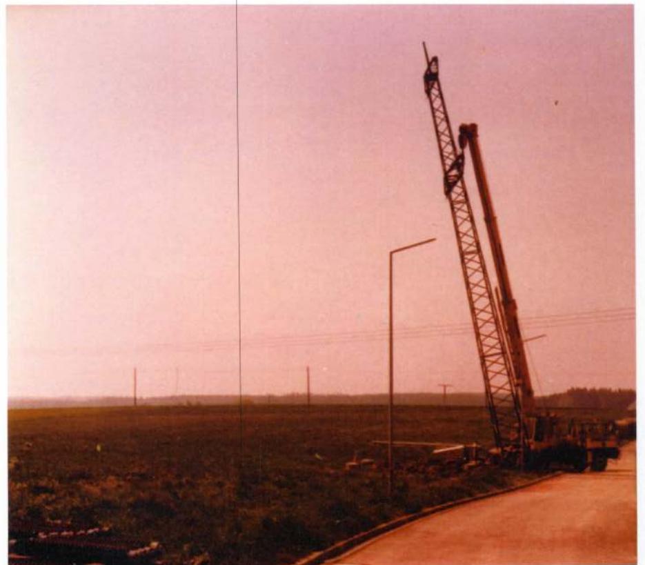
Mast wird abgebaut und anschließend gekürzt
