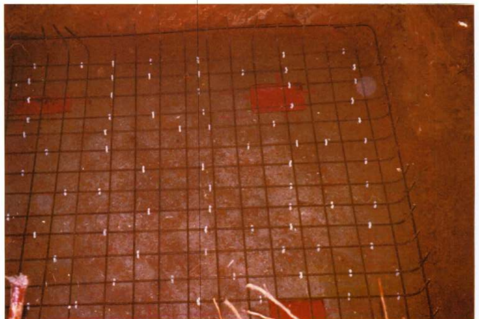
Das vorbereitete Fundament
