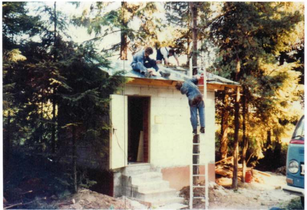
Das Dach wird gedeckt
