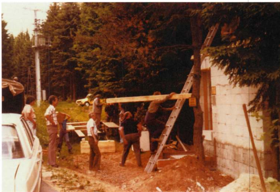
Aufstellen des Dachstuhls
