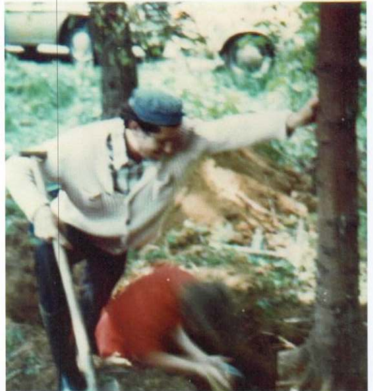
Ausheben des Fundamentes
